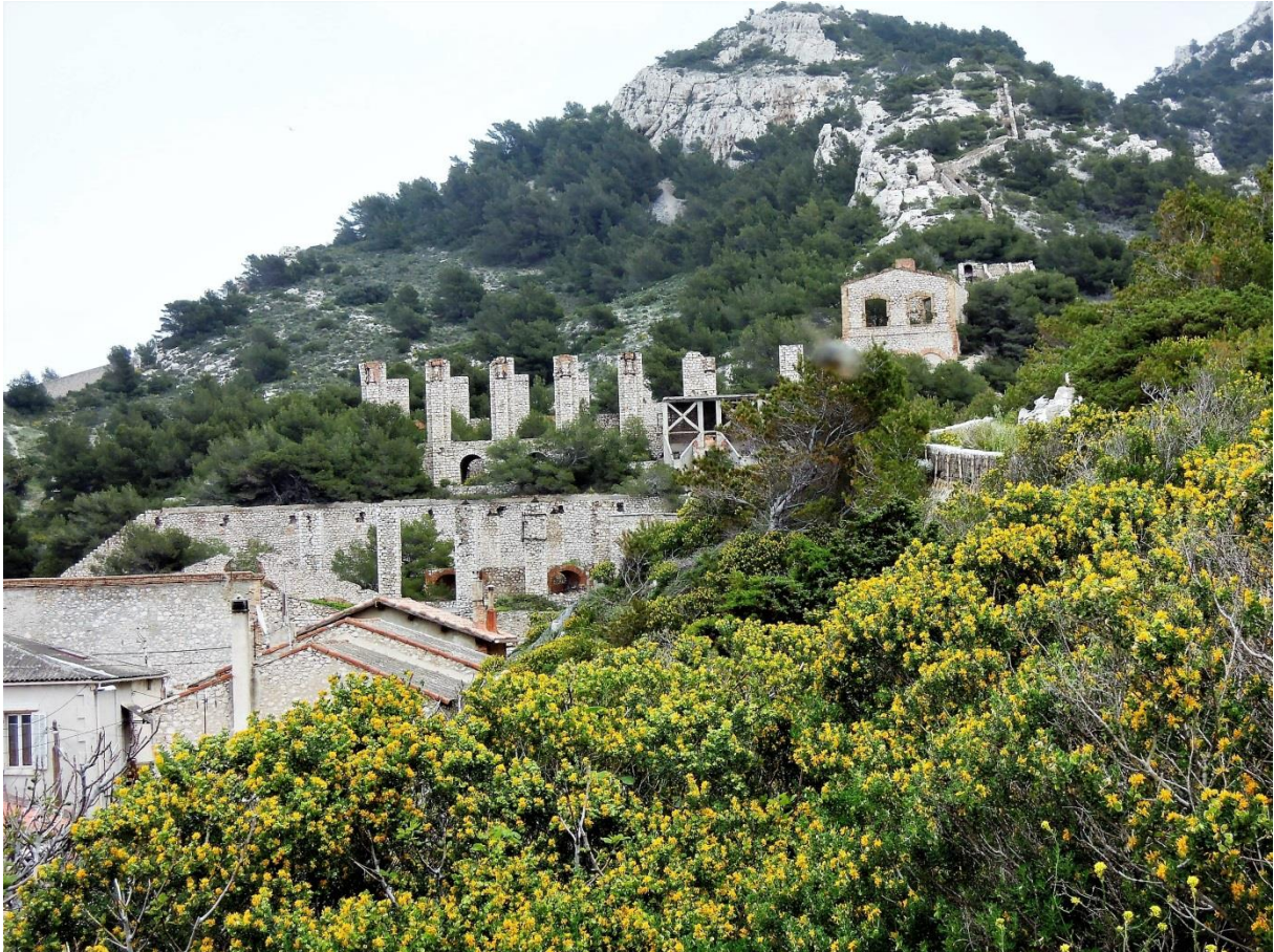
25. La fonderie de l'Escalette, à Marseille ; remarquer, dans le haut de l'image vers la droite, le tracé en baïonnette de la cheminée rampante ; photo P. Fluck
