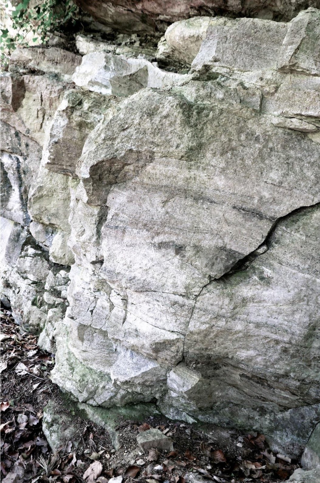
36. Un détail du front de taille de la « carrière à chaux » de Saint-Philippe, à Ste-Marie-aux-Mines. Ce très beau marbre blanc, cristallin, quelquefois chargé de minéraux, fut exploité dès le XVI e siècle pour la production de chaux. Des géologues du monde entier – Guettard, Lavoisier, Monnet, Jung, Teilhard de Chardin – rendirent visite à cette carrière historique. En haut de l'image, le « toit » du calcaire, fait de gneiss à grenat. À mi-hauteur, une lentille d'amphibolite. Hauteur de la photo env. 2 m. Photo P. Fluck.
