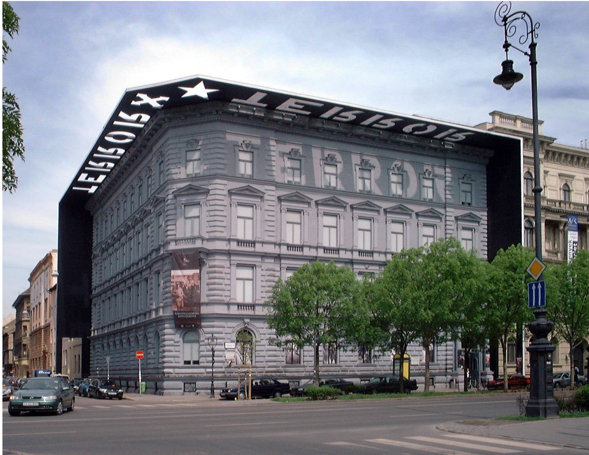
Illustration 12 : Le bâtiment du 60 Andrassy út, qui abrita le siège des Croix fléchées puis celui de la police politique communiste, a été transformé en un musée controversé baptisé « La maison de la terreur » (Terror Háza Múzeum). C'est dans ses caves qu'étaient installées les cellules où étaient enfermés les opposants politiques. Droits réservés.
