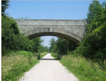
Figure 1. Le pont de la Millette, Tarn (France)
