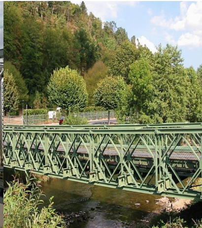
Figure 3. : Pont Bailey sur la Meurthe, France [1].
