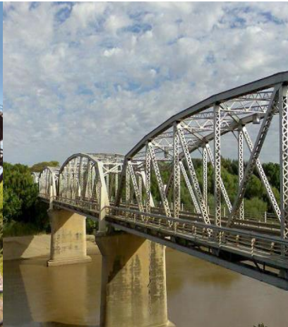
Figure 2. : Pont à quatre travées à treillis sur le fleuve Orange à Aliwal North [1].
