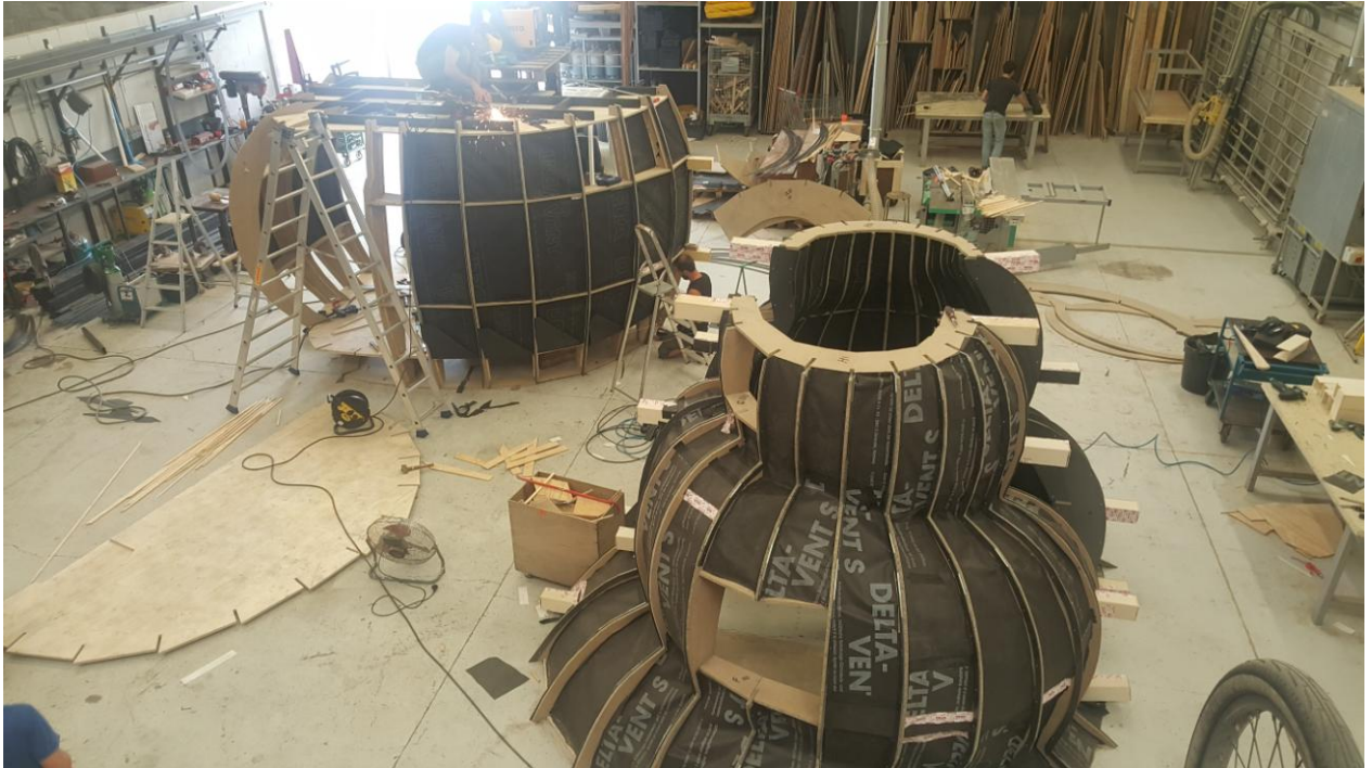
Zébra3, atelier principal, réalisation du refuge péri-urbain « Neptunéa » de Mrzyk et Moriceau, Nouvelle-Aquitaine
