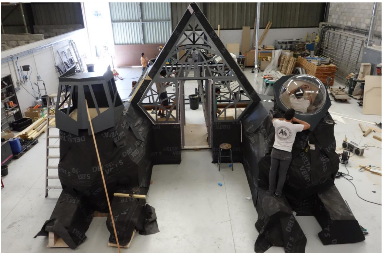
Zébra3, atelier principal, réalisation du refuge péri-urbain « Le Prisme » de Lou-Andréa Lassalle, Nouvelle-Aquitaine
