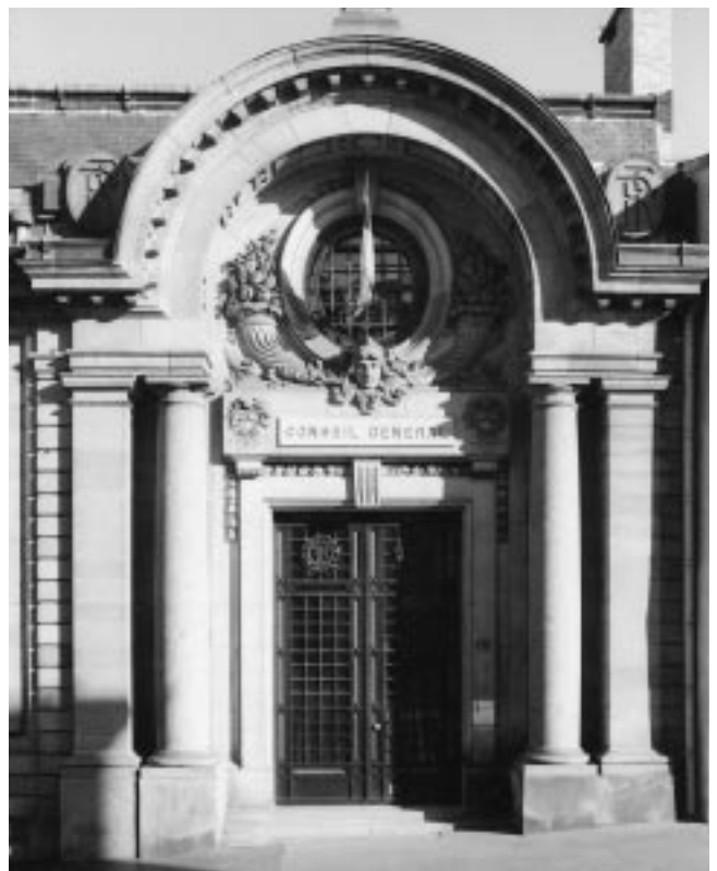
Porte d'entrée de l'ancienne salle des examens actuellement entrée de l'hôtel du département (Philippe Rivière © Inventaire Limousin).
