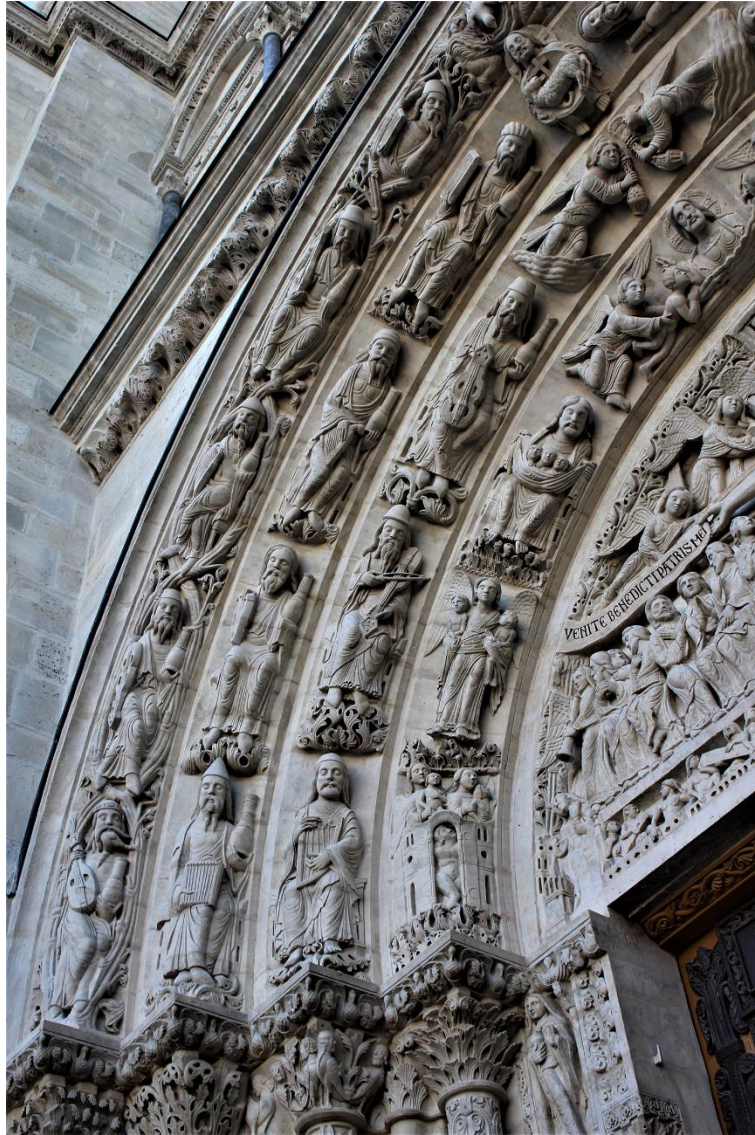
Fig. 2. Détail des voussures et du tympan du portail central, façade occidentale, basilique de Saint-Denis (cl. E. Vernerey).
