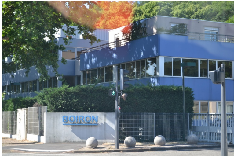
Usine de Sainte Foy Les Lyons
