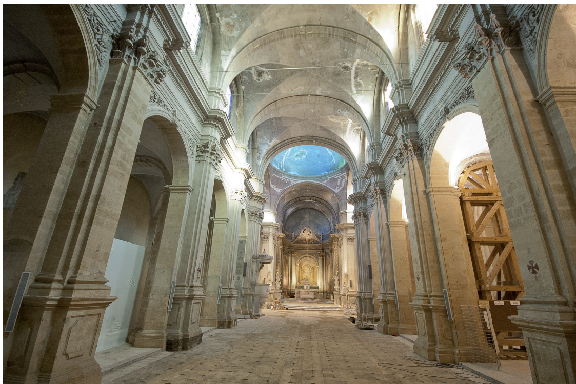
Fig. 16 – Élévations intérieures de l'église depuis l'ouest (cl. G. Thomann).
