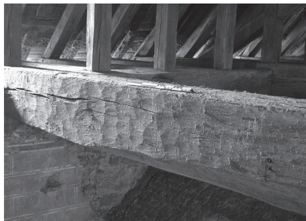
Fig. 5 – Abbaye de Floreffe (B.), toiture de la nef de l'abbatiale, traces de hache sur du chêne abattu en 1227-1237d. Photo : P. Hoffsummer ULG-CEA.
