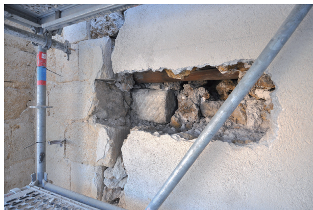
Fig. 17 – Poutre de chaînage insérée dans la maçonnerie du mur ouest du bras nord du transept (cl. S. Claude, DAMVA).
