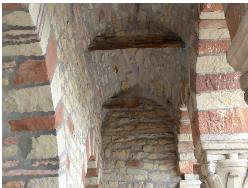
Fig. 6 – Trèves, cathédrale, galerie inférieure sud du massif occidental : tirant en bois (1046d) scié lors des prélèvements opérés dans les années 1970 (cl. A. Hartmann-Virnich).
