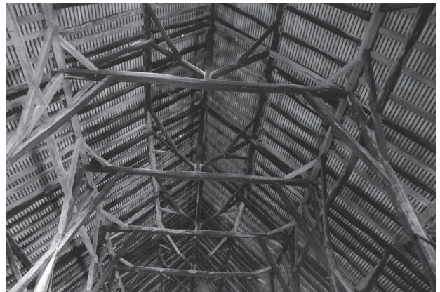
Fig. 14 – Vermenton (Yonne), église Notre-Dame, charpente du chœur (1300-1314d) construit en édifice halle à trois nefs. Hoffsummer, Lambert, Weitz 2012. Photo : P. Hoffsummer ULG-CEA.
