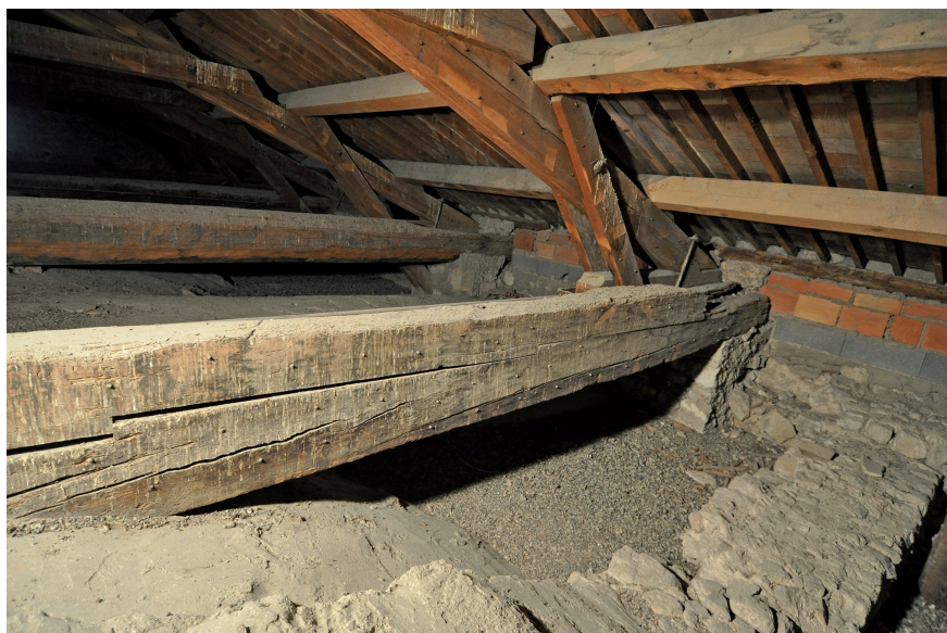
Fig. 14 – Entrain armé n°5 conservé au niveau de la troisième travée de la nef, vu depuis le sud-est (cl. S. Claude, DAMVA).
