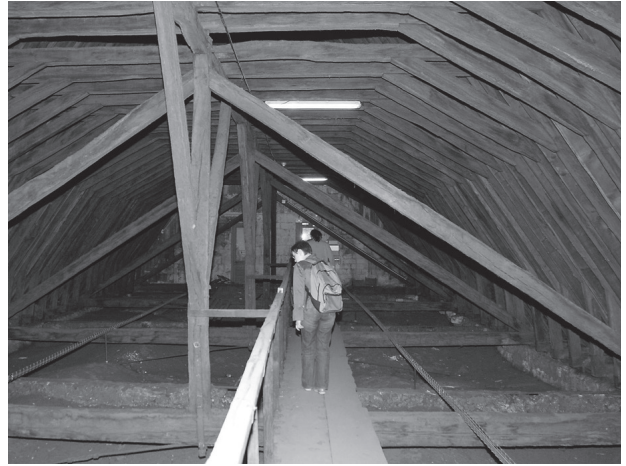
Fig. 9 – Paris, ancien prieuré de Saint-Martin-des-Champs, toiture de l'ancien Réfectoire, début 1215-1220d (Hoffsummer, 2002). Photo : P. Hoffsummer.
