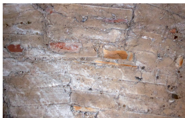
Fig. 3 – Trèves, cathédrale, d'escalier d'angle sud, planchette résiduelle du coffrage de la voûte hélicoïdale (vers 1042-1044) (cl. A. Hartmann-Virnich).
