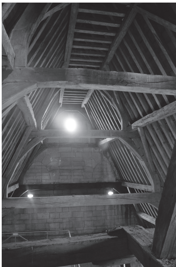
Fig. 12 – Bruxelles, église N.-D. du Sablon, charpente du bras sud du transept (1451-1453d) construite selon le modèle des toitures brabançonnnes à portiques. Photo : P. Hoffsummer ULG-CEA.
