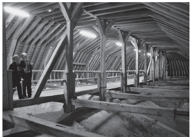
Fig. 11 – Beauvais (Oise), cathédrale Saint-Pierre, charpente du chœur (1257-1258d avec modifications après 1573 et au XVIII e siècle). Photo : P. Hoffsummer ULG-CEA.
