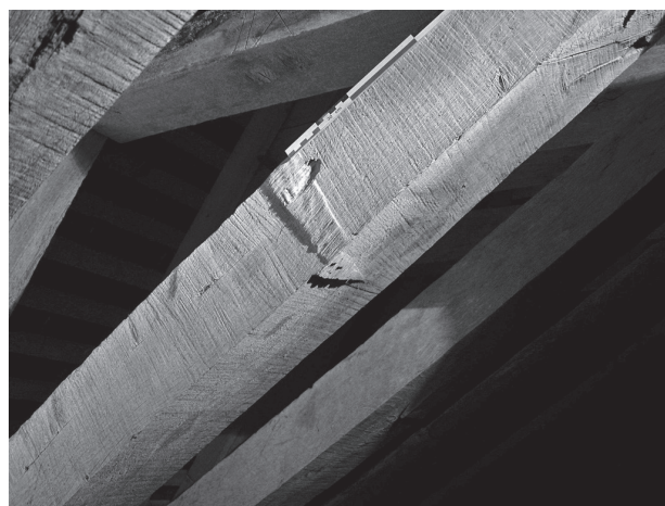
Fig. 17 – Cour-Cheverny (Loir-et-Cher), château de Cheverny, aile entre l'escalier central et le pavillon est, 1627-1628d. Traces de la scie à cadre. Photo : P. Hoffsummer ULG-CEA.
