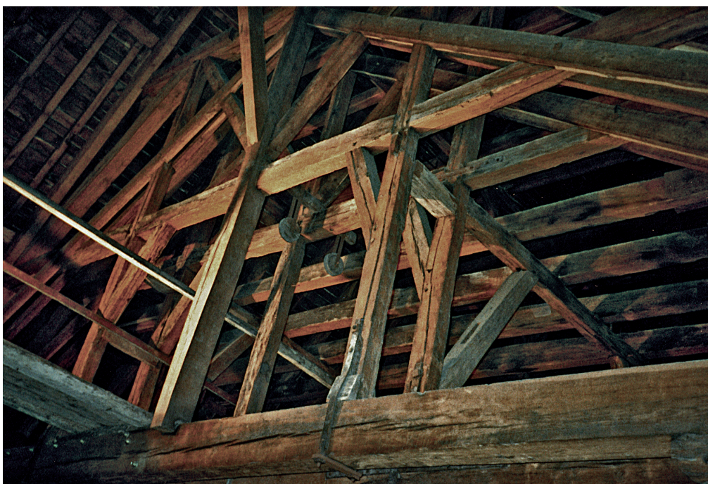
Fig. 4 – Ferme principale de la nef (photo: G. Lambert, 1994).
