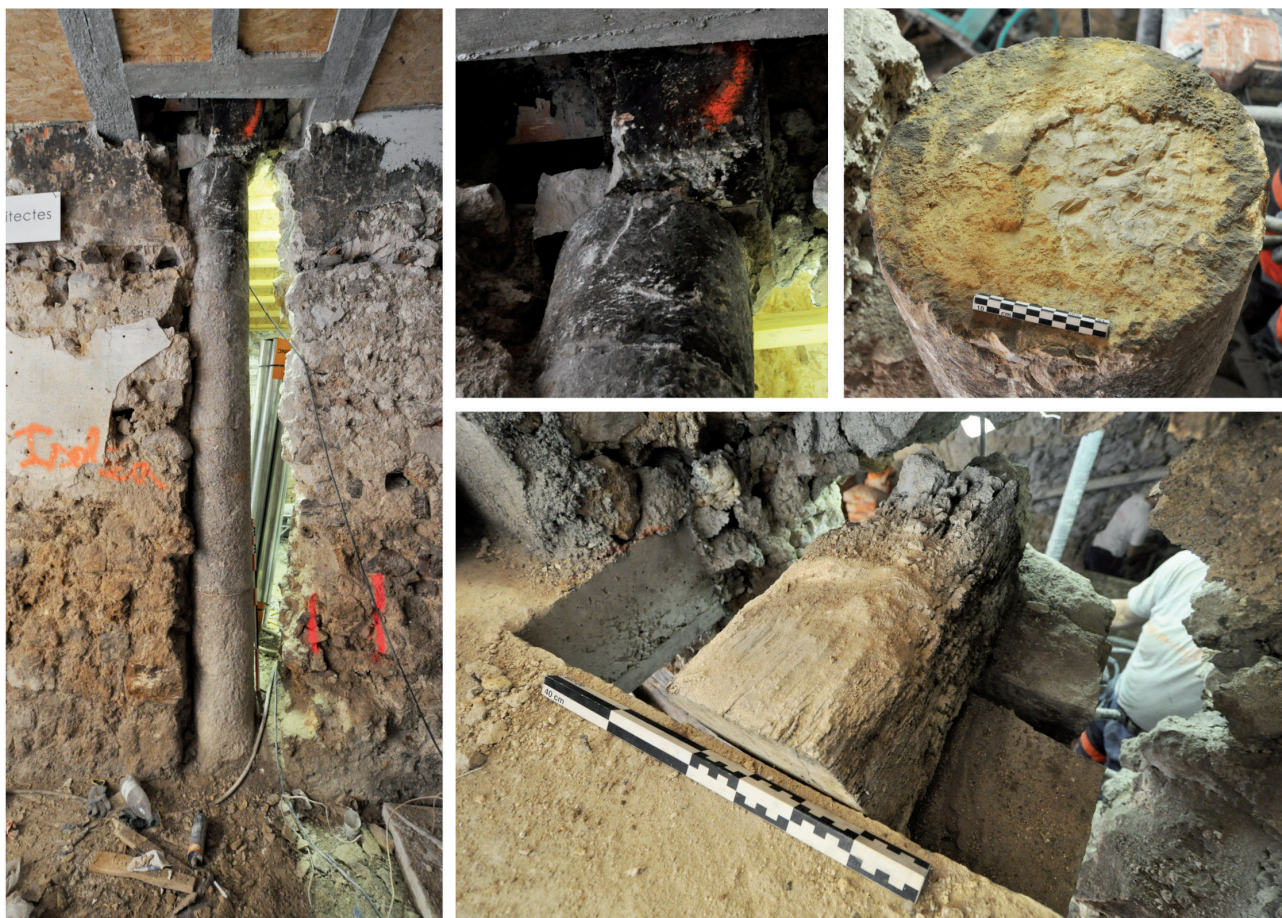
Fig. 2 – Îlot Sainte-Marthe: suivi de démontage d'un plancher dont une poutre sciée sur colonne était encore en place (clichés: F. Blanc).
