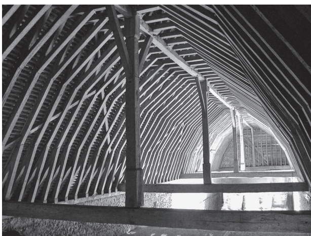
Fig. 16 – Exemple du type «1.3.1.6.1» (Hoffsummer 2011, 115-120). Charpente à chevrons formant fermes contreventée par une ou plusieurs sous-faîtières et une panne faîtière, alternance de fermes à entrait et de fermes à entrait retroussé, poinçon, jambettes et aisseliers, à un seul étage de faux-entrait : Sargé-sur-Braye (Loir-et-Cher), château des Radrets, grange. Photo : P. Hoffsummer ULG-CEA.
