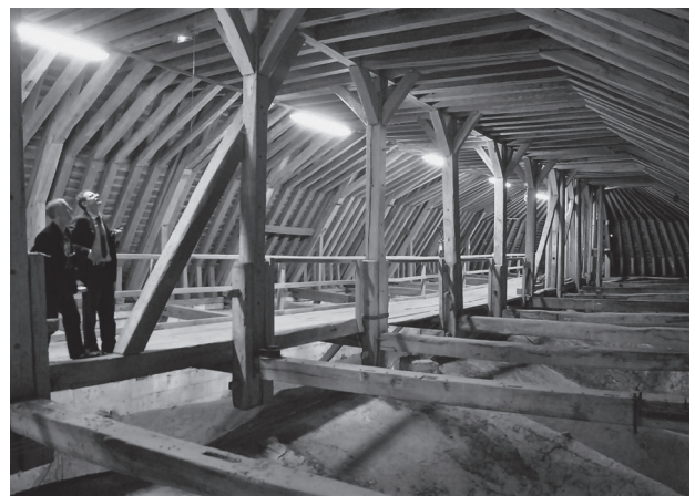
Fig. 11 – Beauvais (Oise), cathédrale Saint-Pierre, charpente du chœur (1257-1258d avec modifications après 1573 et au XVIII e siècle). Photo : P. Hoffsummer ULG-CEA.
