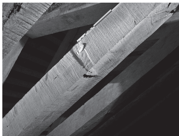
Fig. 17 – Cour-Cheverny (Loir-et-Cher), château de Cheverny, aile entre l'escalier central et le pavillon est, 1627-1628d. Traces de la scie à cadre. Photo : P. Hoffsummer ULG-CEA.
