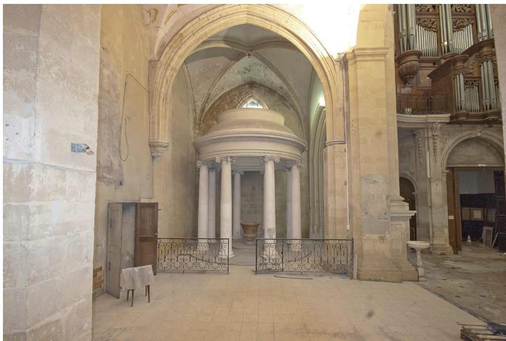
Fig. 10 – Vue de la travée occidentale de la chapelle du roi (cl. G. Thomann).
