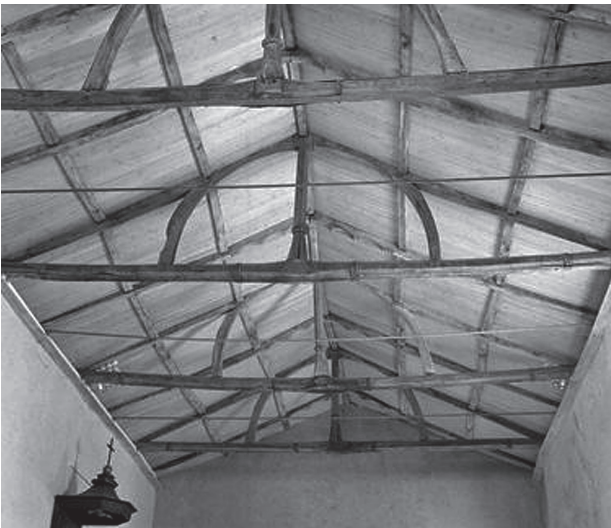
Fig. 7 – Église de Langeronde (Vendée), charpente du type « bordelais » à fermes et pannes. Médiathèque de l'architecture et du patrimoine, Diffusion RMN.
