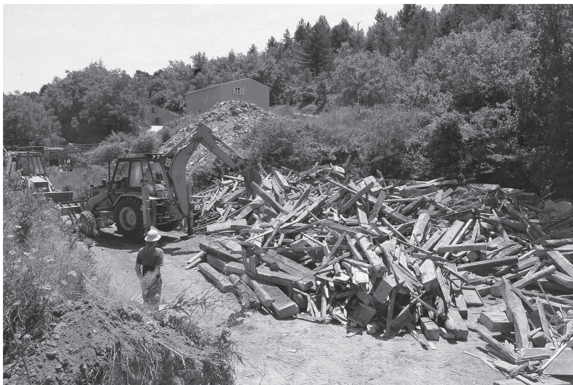
Fig. 2 – Pendant la déconstruction, certains éléments en bois ont été entreposés sur une aire de stockage, un terrain municipal à l'extérieur du centre-ville (cliché: L. Shindo).
