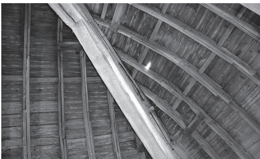
Fig. 16 – Exemple du type «1.3.1.6.1» (Hoffsummer 2011, 115-120). Charpente à chevrons formant fermes contreventée par une ou plusieurs sous-faîtières et une panne faîtière, alternance de fermes à entrait et de fermes à entrait retroussé, poinçon, jambettes et aisseliers, à un seul étage de faux-entrait : Sargé-sur-Braye (Loir-et-Cher), château des Radrets, grange. Photo : P. Hoffsummer ULG-CEA.
