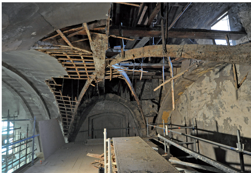
Fig. 18 – Charpente moderne de la première travée du vaisseau central de la nef (cl. S. Claude, DAMVA).
