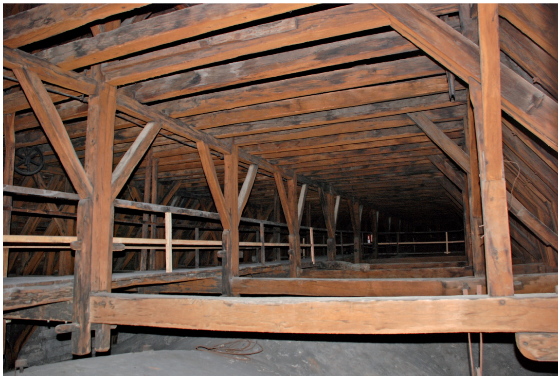
Fig. 7 – Charpente à chevrons formant fermes, à arbalétriers monoxyles, où alternent fermes à entrait et fermes à entrait retroussé, contreventées par des liernes ou des filières, renforcées de sous-arbalétriers d'inclinaison plus douce que les versants, éventuellement équipées de suspentes (photo : G. Lambert, 1994).
