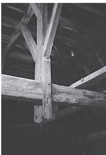
Fig. 4 – Ferme principale de la nef (photo: G. Lambert, 1994).
