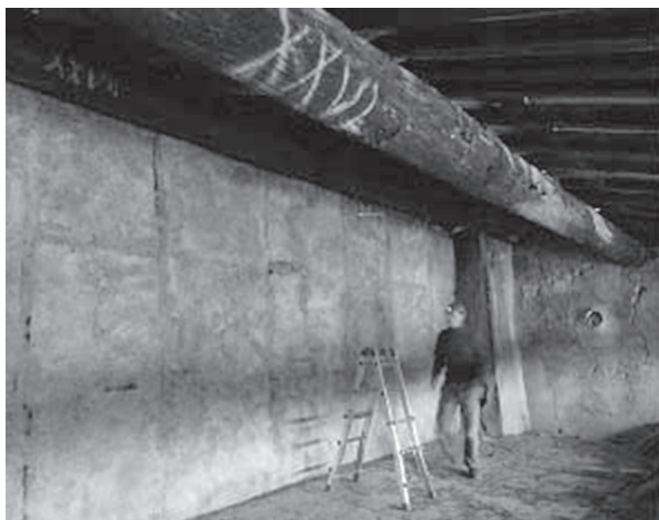
Fig. 13 – La panne faitière, marquée «XXVII», au deuxième plan sur la photographie de gauche, est située dans l'ombre au sommet de la cloison. Elle a été échantillonnée sous forme de section (0416601_54, photographie de droite). La panne au premier plan («XXVI») a été carottée mais n'est pas datée pour l'instant (clichés: L. Shindo).
