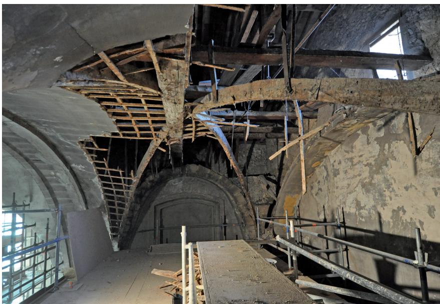
Fig. 18 – Charpente moderne de la première travée du vaisseau central de la nef (cl. S. Claude, DAMVA).
