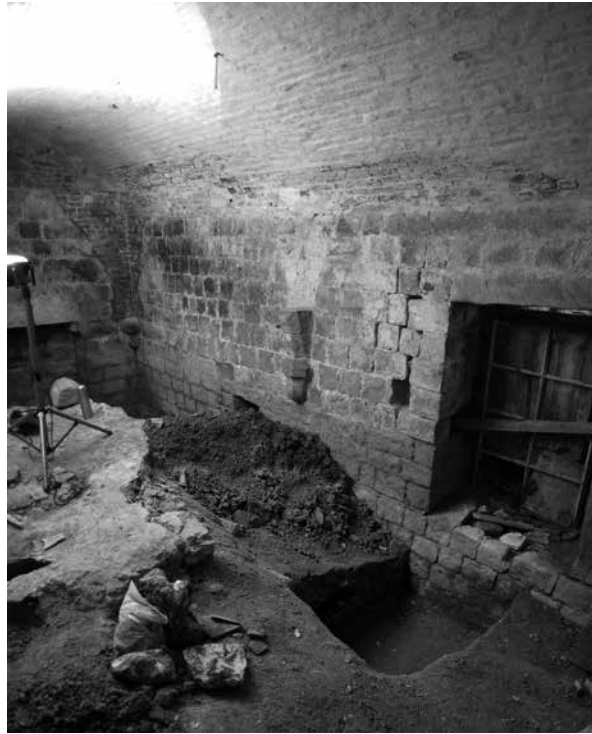
Fig. 4. Bours, le donjon, vue du contexte d'intervention dans la cave du donjon. Cl. V. Merkenbreack, CDA – CG62.
