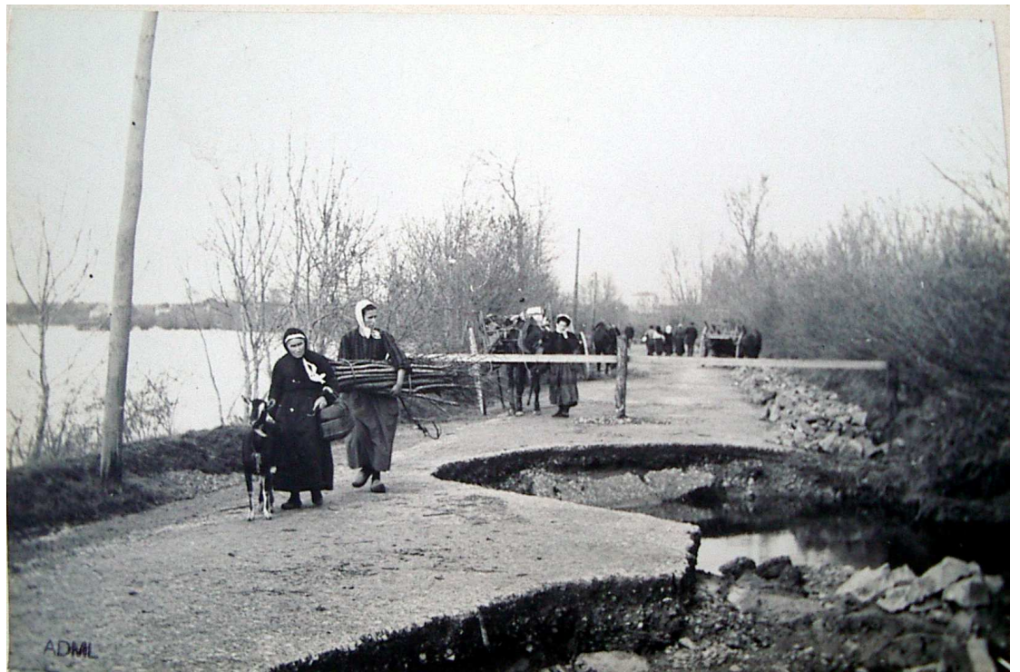
Fig. 4. Inondation de 1910. Début de brèche, route de Chalonnnes sur Loire à St Georges sur Loire. ADML : 4 Fi 4902
