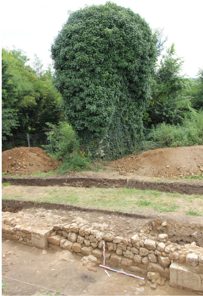
Fig. 10 : tranchée 1, vue de l'ouverture EA1 du bâtiment 7, bouchée par les murs 44 et 27. Au fond, noyé dans la végétation, le pan de mur du bâtiment 7 encore en élévation (cliché E. Normand)
