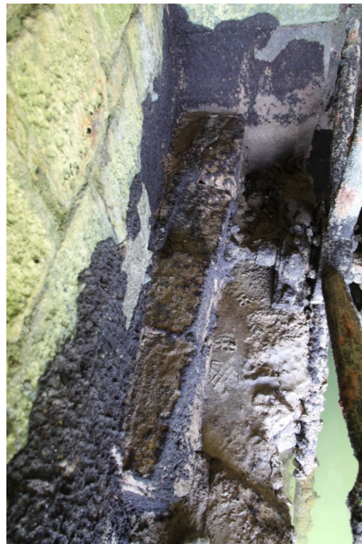
Fig. 9 : Vue de l'insertion du mécanisme dans des substructions antérieures liées au premier état de fonctionnement. On remarque les deux orientations différentes des maçonneries (cliché : B. Gissinger)
