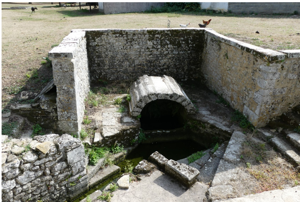
Figure 3 bis : Logis de Feusse, le lavoir.
