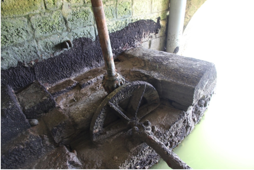
Fig. 8 : Roue crantée entraînant le mécanisme (cliché : B. Gissinger)
