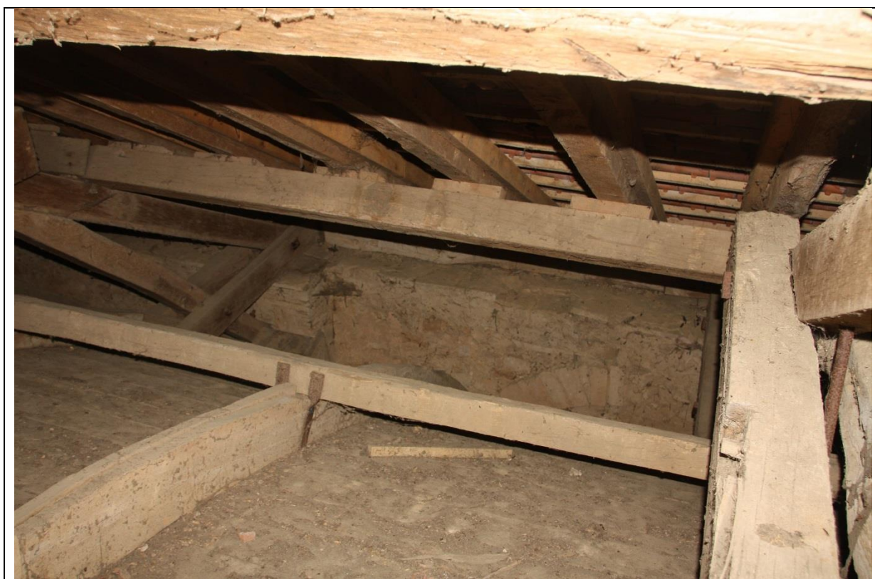
Fig. 64 : Arc du mur nord de la nef visible sur dans les combles de la nef de l'église paroissiale (Cliché S. Durand)
