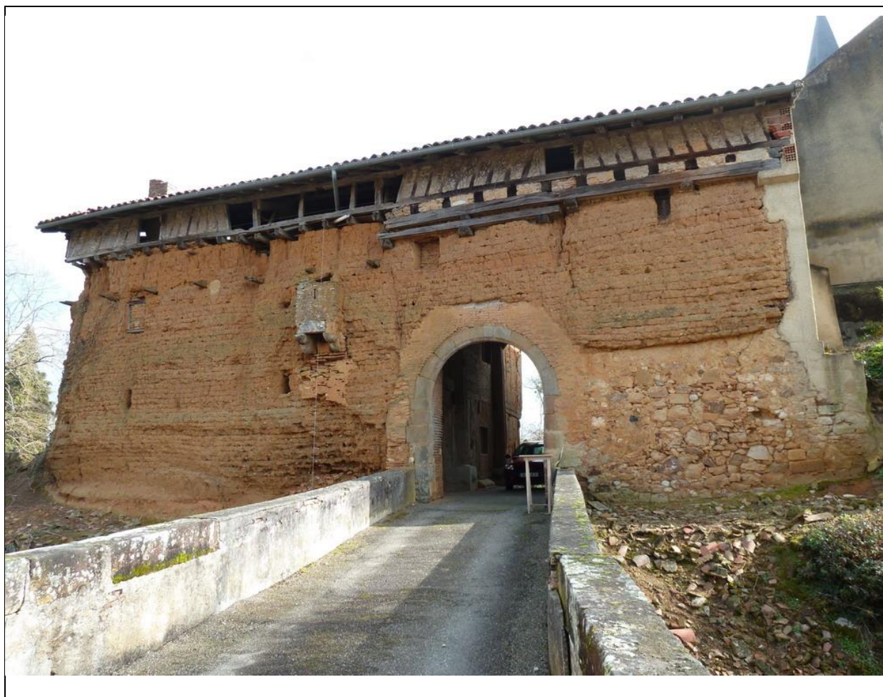
Fig. 35 : Façade ouest du rempart en terre massive (A. Klein)
