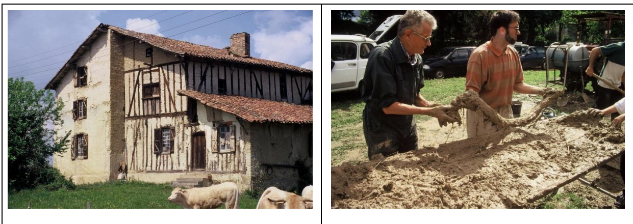
Fig. 20 et 21 : A gauche, ferme d'Enbazil à Puymaurin (31). Partie droite : pan de bois hourdé au torchis (XVII e siècle). Partie gauche : reconstruction en adobes au XIX e siècle et à droite Musée du paysan gascon à Toujouse (32) : dégagement d'un boudin de 1,20 m de longueur environ de la table de travail, prêt à être livré sur le chantier. 200
