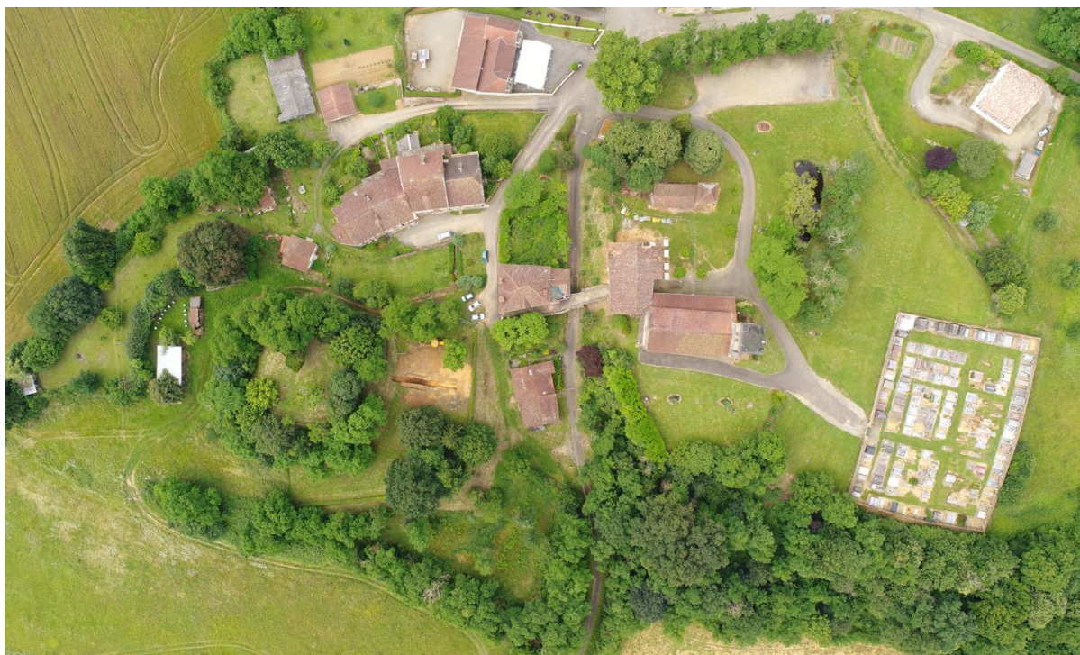
Fig 59 : Photographie aérienne du village de Sainte-Christie-d'Armagnac en juin 2018 avec la motte à l'ouest et le Castet à l'est (cliché par drone : S. Durand).
