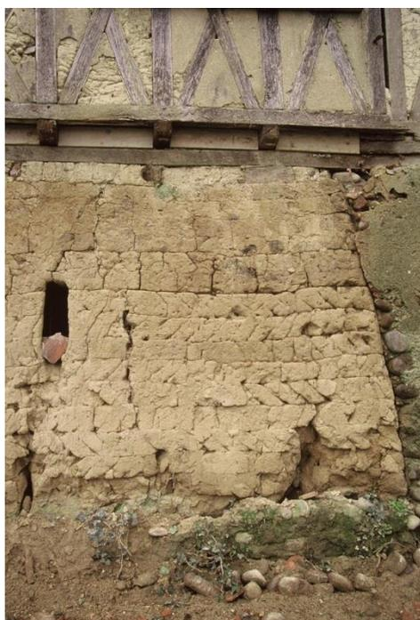
Fig. 27 : habitation à Sariaac-Magnoac (65). Rez-de-chaussée en bauge procédant par pains disposés en obliques (opus spicatum). Etage en colombage-torchis. XVI-XVII<sup>e</sup> siècle.
