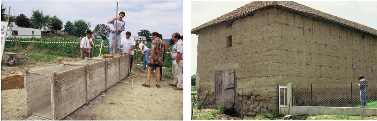
Fig. 25 : Réalisation d'une portion de mur, à l'aide d'un ancien coffrage à pisé, en 1995. Origine du coffrage : Guizérix (65). Coffrage en chêne, traverses métalliques. Dimensions du coffrage : 4,47 x 0,80 m (hauteur). A droite, ferme de Cho à Mont-d'Astarac (32). Les lignes horizontales des banchées et les trous de traverses sont parfaitement discernables. Banchées de 3,83 x 0,70 x 0,53 m (épaisseur).
