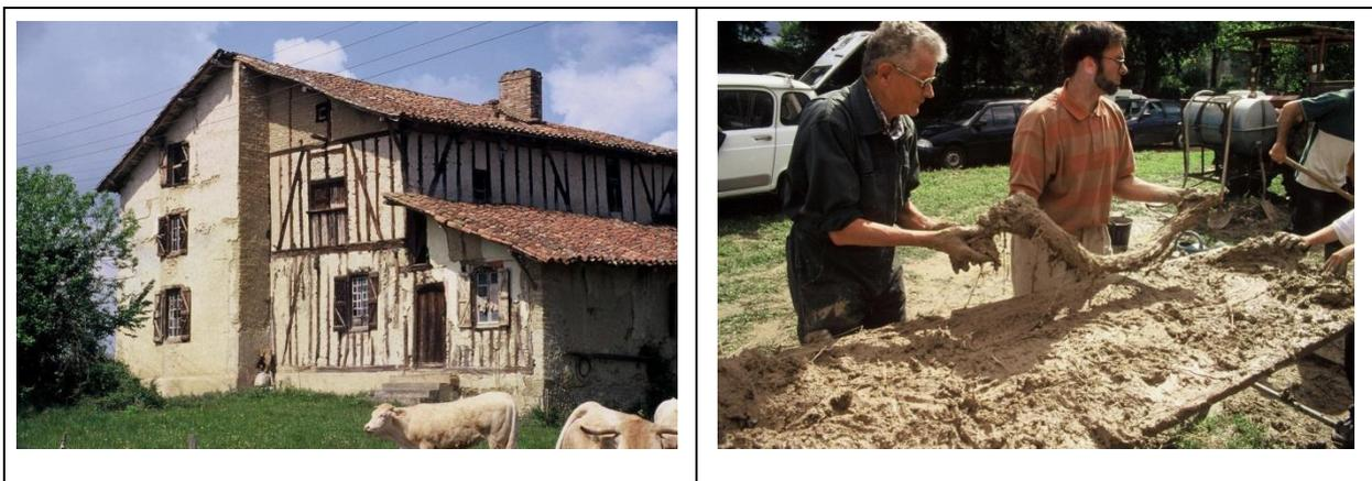
Fig. 20 et 21 : A gauche, ferme d'Enbazil à Puymaurin (31). Partie droite : pan de bois hourdé au torchis (XVII<sup>e</sup> siècle). Partie gauche : reconstruction en adobes au XIX<sup>e</sup> siècle et à droite Musée du paysan gascon à Toujouse (32) : dégagement d'un boudin de 1,20 m de longueur environ de la table de travail, prêt à être livré sur le chantier. 200
