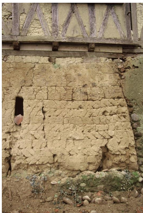
Fig. 27 : habitation à Sariac-Magnoac (65). Rez-de-chaussée en bauge procédant par pains disposés en obliques (opus spicatum). Etage en colombage-torchis. XVI-XVII e siècle.
