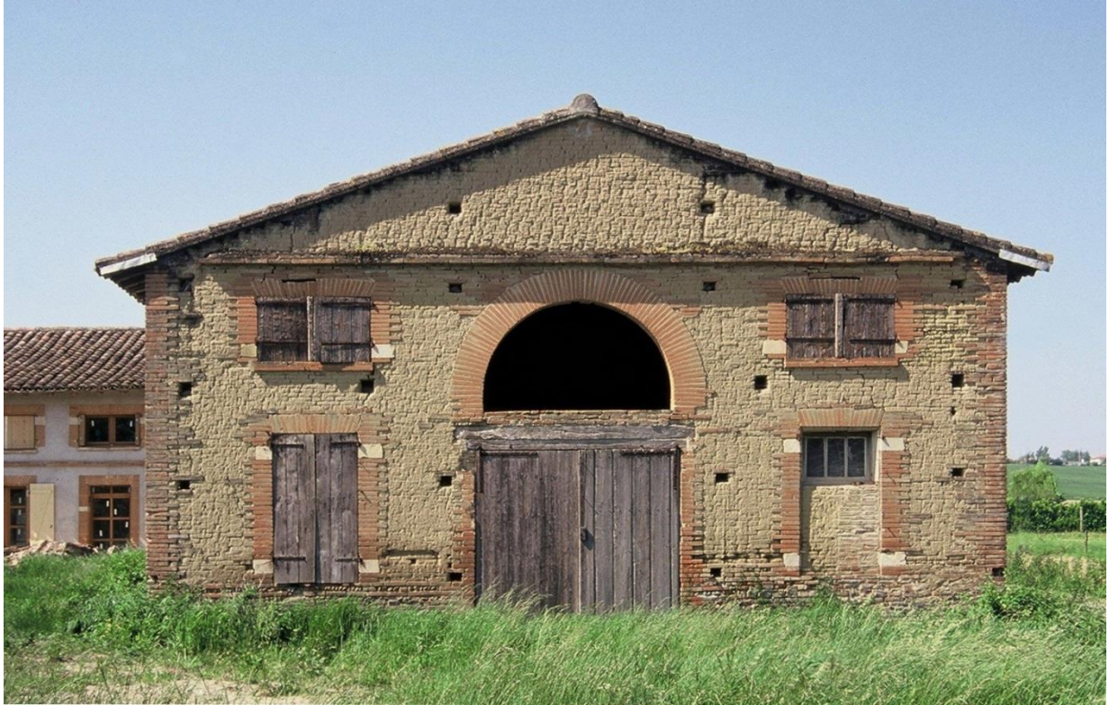
Fig. 29 : Ferme de Caucat à Gragnague (31), associant briques de terre crue et cuite pour les parties d'ouvrages fortement sollicitées (solin, encadrements d'ouverture, chaînes d'angle, corniche)
