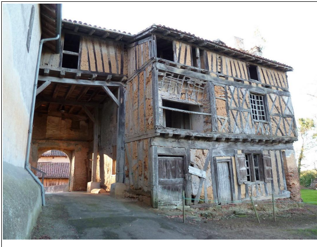
Fig 36 : Angle sud-est du logis (A. Klein)
