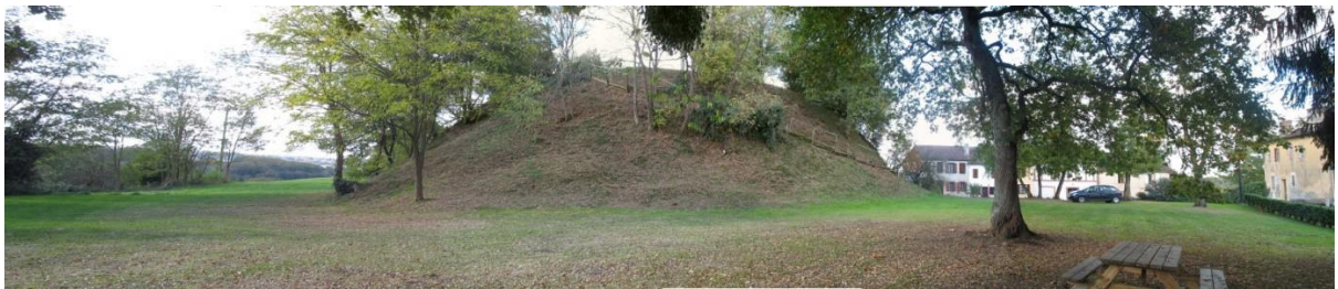
Fig 54 : Vue panoramique de la motte de Sainte-Christie-d'Armagnac, prise depuis le sud-est (cliché : N. Guinaudeau).
