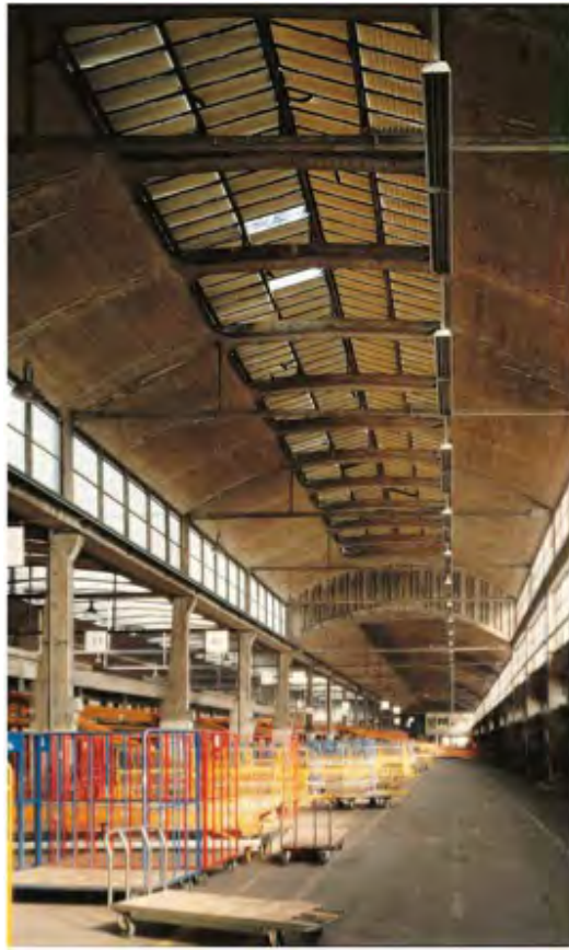
Fig. 5. Vue intérieure de la Halle dite « Freyssinet » en fonctionnement en 2006. © Semapa
