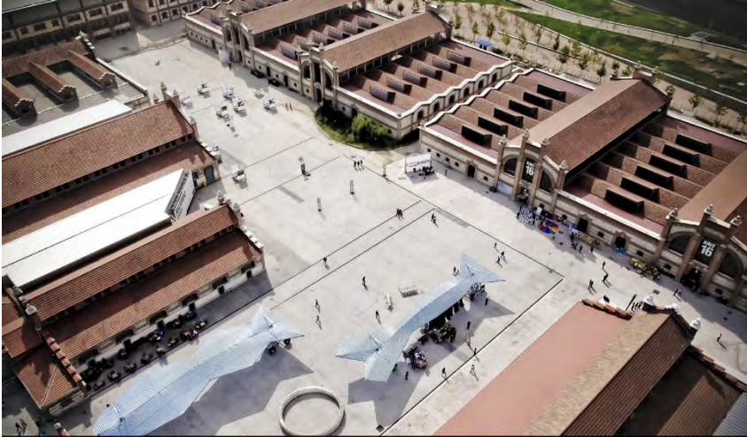
Fig. 4. Fotografía aérea del centro cultural El Matadero. Sin fecha. Autor(es): Paco Gomez/Matadero Madrid. Fuente: http://www.mataderomadrid.org/prensa.html
