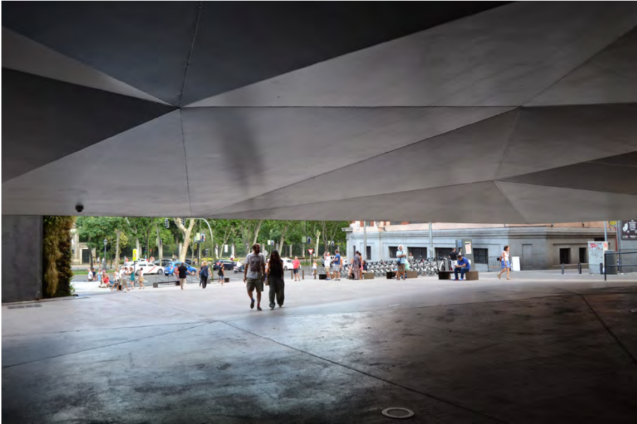
Fig. 5. Plaza bajo el Centro Cultural CaixaForum (Fotografía Á. Layuno).
