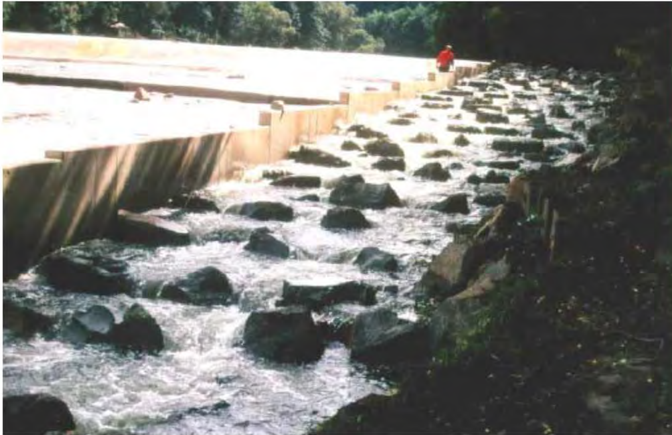
Enrochements en rangées périodiques
