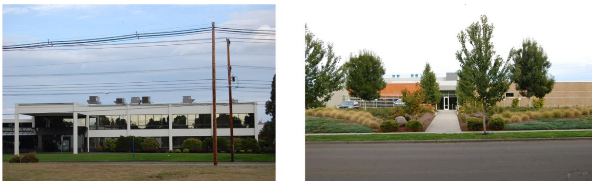
Figure 17. Data centers d'OVH et d'Adobe à Hillsboro Crédits=© Cécile Diguët et Fanny Lopez, 2018.
