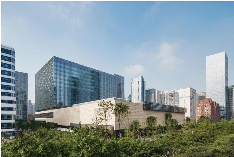
Figure 7. Data center de Gensler à Chengdu, Crédits=© Gensler, 2017.
