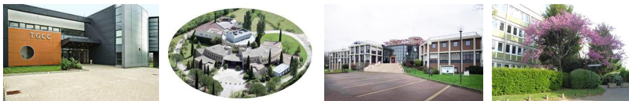
Figure 35. Les 4 data centers nationaux: TGCC à Bruyères-le- Châtel, le CINES à Montpellier, CC- IN2P3 à Villeurbanne, IDRIS à Orsay =© Ministère de l'Enseignement supérieur et de la Recherche.
