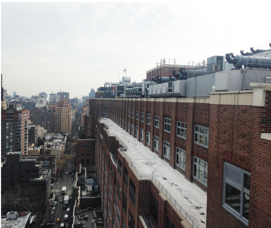
Figure 24. Toiture du 111 8th avenue Crédit =©Cécile Diguet et Fanny Lopez, 2018.
