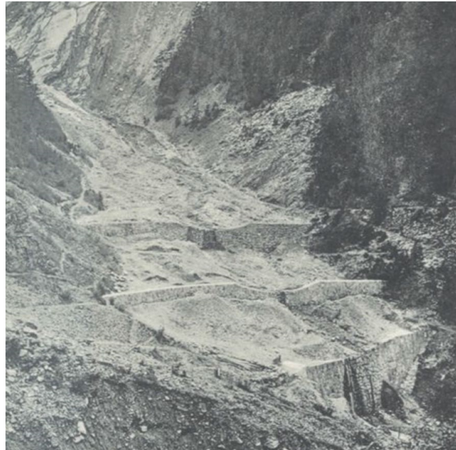
Figure 4 : Illustration historique d'un barrage de rétention situé dans la partie supérieure d'un bassin versant torrentiel
