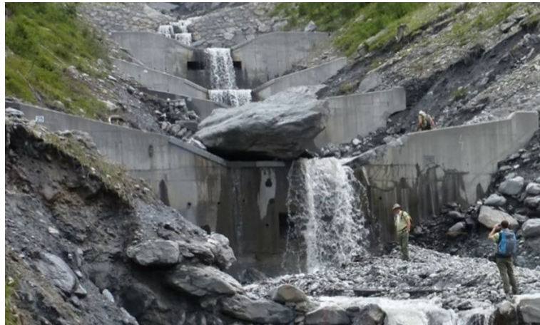
Figure 11 : Illustration de l'effet d'arrêt des blocs rocheux par les barrages
