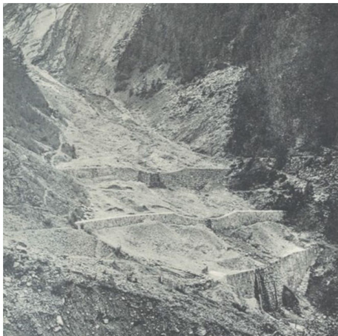
Figure 4 : Illustration historique d'un barrage de rétention situé dans la partie supérieure d'un bassin versant torrentiel
