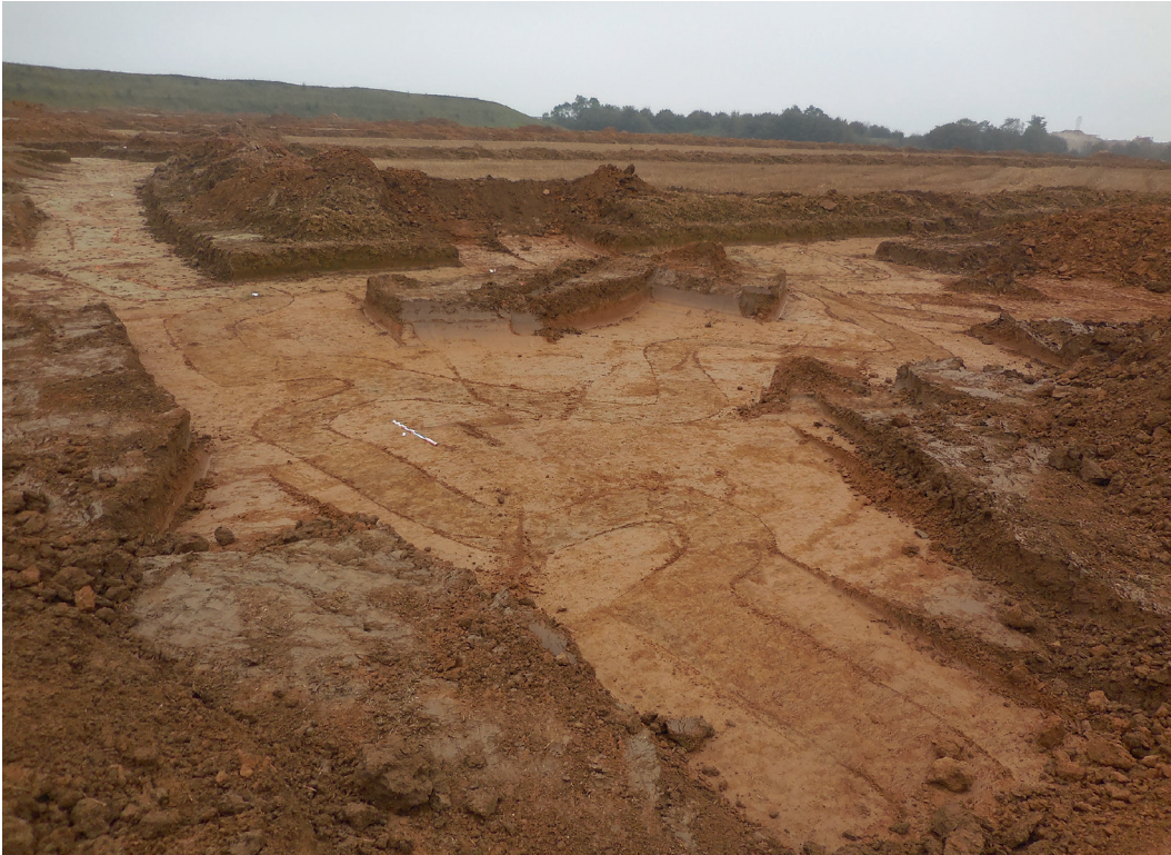
Figure 5 – Tranchée à traverses et réseau se développant vers l’arrière. Moussy-le-Neuf (Seine-et-Marne). Mire d’1 m. [© Cliché : G. Mercé, Inrap]
