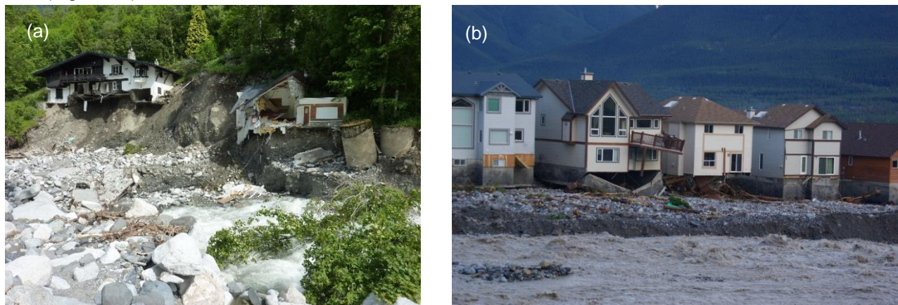
Figure 29 : Exemples d'action d'érosion/d'affouillement après (a) les événements de Juin 2013 dans les Pyrénées, France (Photos credits : RTM / Irstea) ; et (b) l'événement à Cougar Creek, Alberta en 2013 (Photos credits : BGC ENGINEERING INC.).
