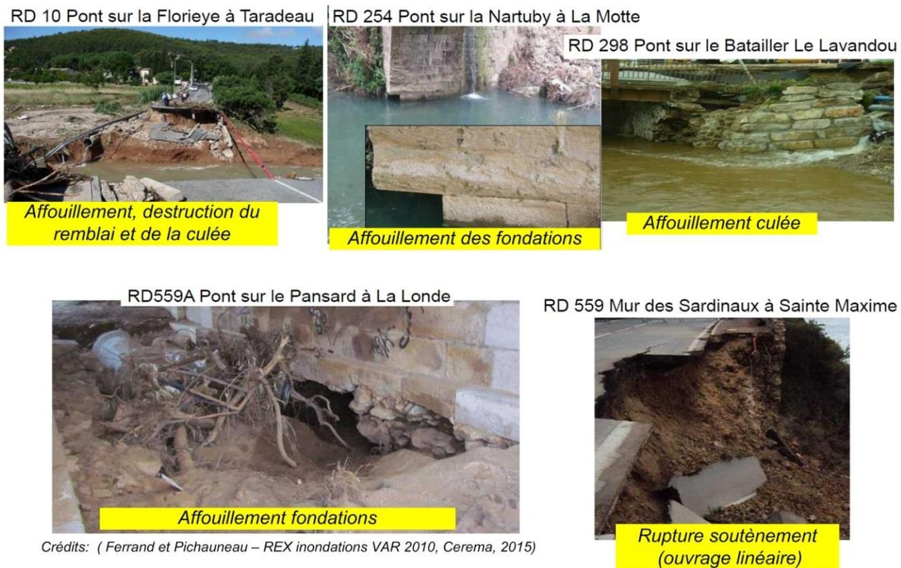
Figure 11 : Exemples de dommages aux ouvrages d'art par affouillement (Feraud and Picheneau 2015)
