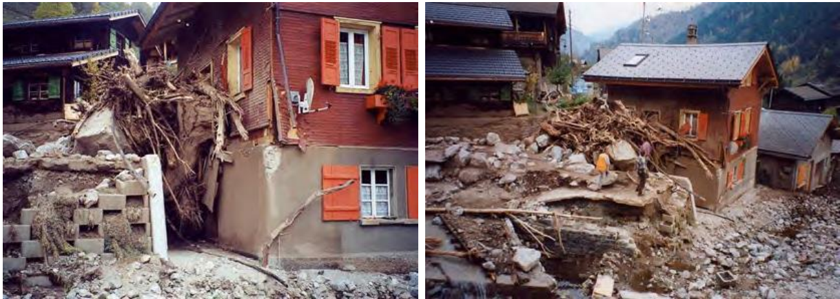
Figure 18 : Accumulation de flottants venus impacter un bâtiment avec pourtant un minimum de dégâts : Valais suisse, 2000 (© Robert Marie, ONF-RTM38)
