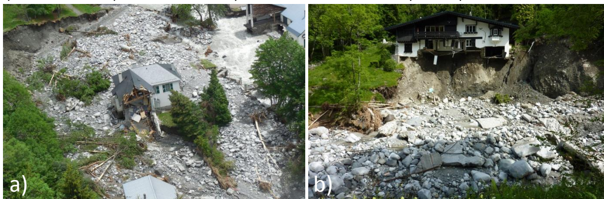
Figure 15 : Affouillements : (a) baraque RTM de Barège sur le Bastan en Juin 2013 (© ONF-RTM65) et (b) maison de particulier plus en amont (© Guillaume PITON)
