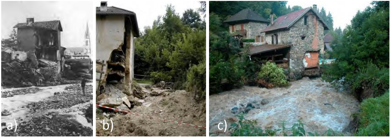
Figure 16 : Vulnérabilité des angles des bâtiments en maçonnerie ((a) © photo d'époque DR, (b) ONF-RTM 38 et (c) Yannick Guigal, IRMa)
