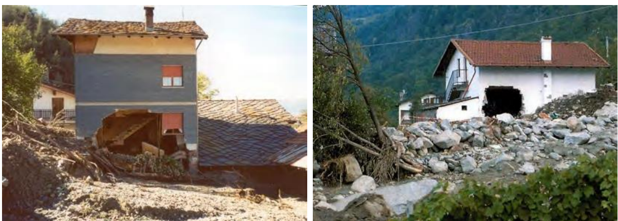
Figure 20 : Destruction de murs par impact de blocs : Val d'Aoste 2000 (© Région Autonome Vallée d'Aoste)
