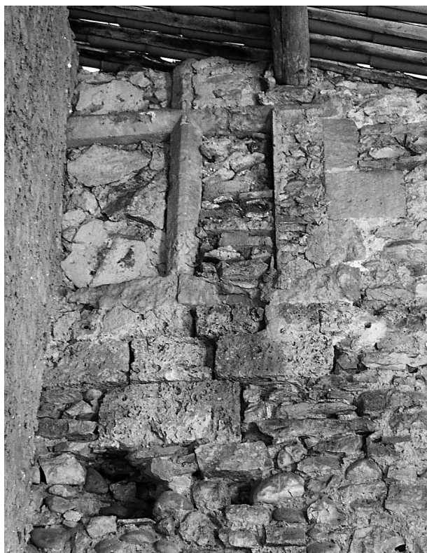
Fig. 4 : Fenêtre à meneau en place dans le mur sud du bâtiment construit en pierre à l'intérieur du bâtiment. Cliché G. Bonnamour (Arkemine).
