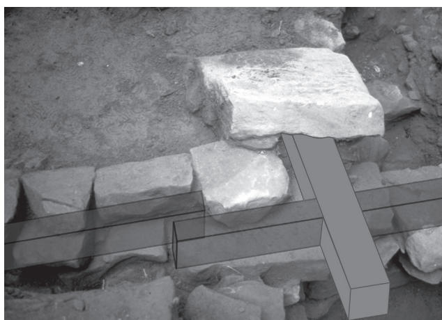
Fig. 2.2: Vue de l'arrière du parement du murus gallicus du Fossé des Pandours, au col de Saverne (Bas-Rhin) avec la restitution du poutrage dans le parement (Cliché et restitution S. Fichtl).
