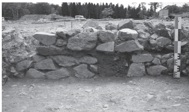
Fig. 2.7: Mont Beuvray. Enclos PC15 du Parc aux Chevaux. Vestiges du murus gallicus: vue du parement depuis l'extérieur, aspect de la construction et remplissages limoneux marquant l'emplacement de pièces de bois transversale et longitudinale (Ph. Barral, M. Joly, P. Nouvel, M. Thivet)
