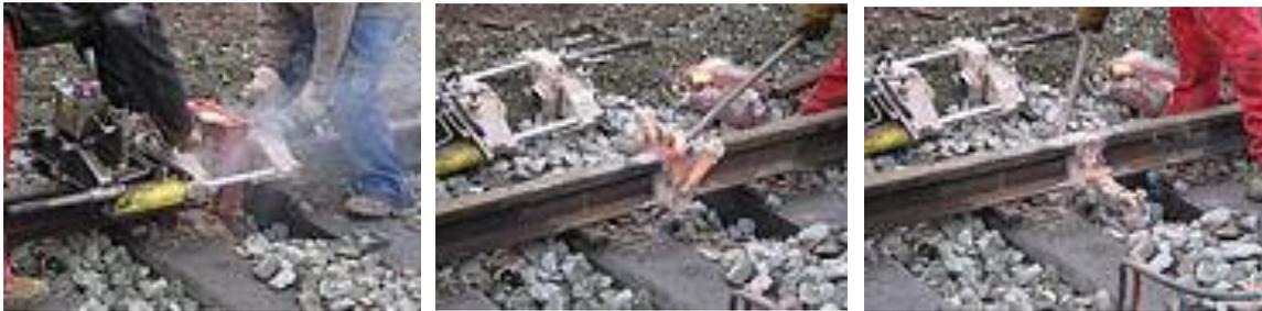
Figure 13. Utilisation d'une thermitite pour le soudage de rails. Les températures atteintes lors des réactions chimiques en phase solide de l'aluminium avec des oxydes de fer sont assez élevées pour permettre le soudage. [https://commons.wikimedia.org/wiki/File:Thermite\\_welding\\_16.JPG](https://commons.wikimedia.org/wiki/File:Thermite_welding_16.JPG)
