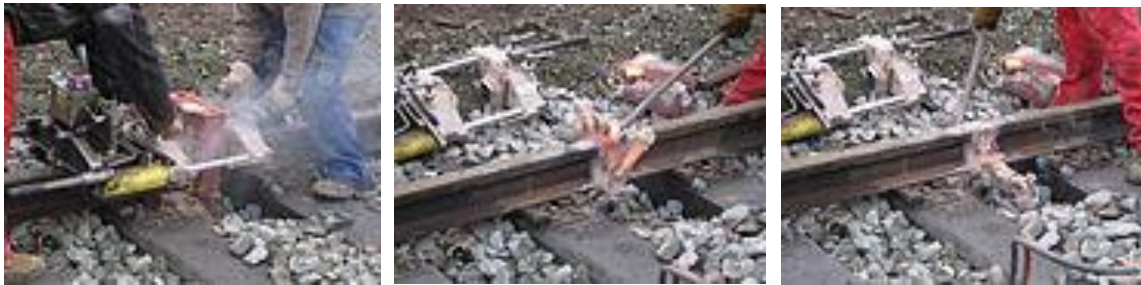
Figure 13. Utilisation d'une thermitte pour le soudage de rails. Les températures atteintes lors des réactions chimiques en phase solide de l'aluminium avec des oxydes de fer sont assez élevées pour permettre le soudage. https://commons.wikimedia.org/wiki/File:Thermite_welding_16.JPG
