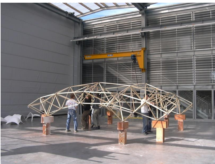
Fig. 7 et 8: En parallèle à l'exercice précédent (en bois), d'autres équipes réalisaient de plus grandes structures : en barres et nœuds avec tasseaux bois et connecteurs métalliques (photo 7) ou des coques en staff (photo 8).
