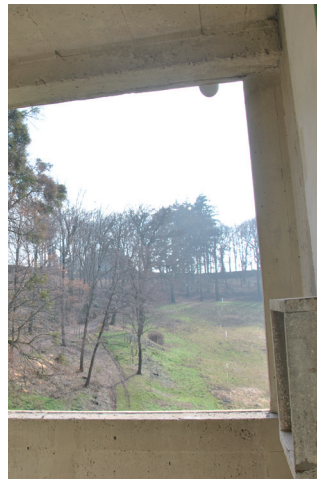
figure 7. Ensemble menuisé d'une cellule et sa loggia à l'arrière et la vue prise en position assise dans une loggia
