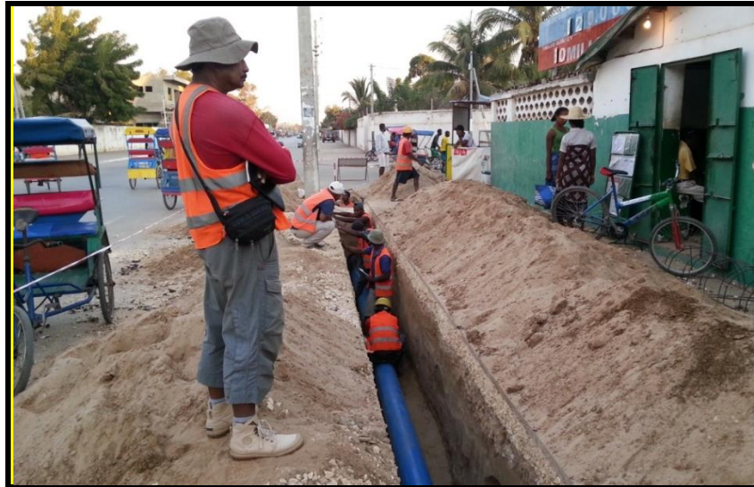
Photo 2: Installation de nouveau tuyau PVC du 17/08/2017 sur la route vers Andaboly (Source : Randriatsitohaina,2017)
