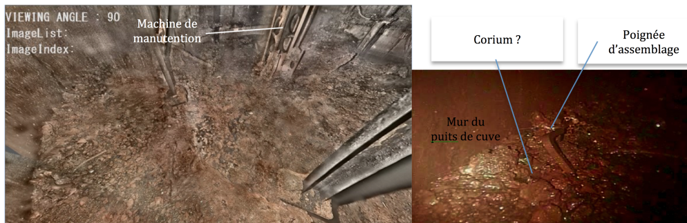
Figure 3: Photographies du puits de cuve de la tranche 2 [13] (gauche : vue d'ensemble reconstituée – droite : zoom près du mur du puits de cuve)
