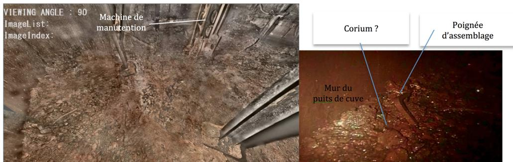
Figure 3: Photographies du puits de cuve de la tranche 2 [13] (gauche : vue d'ensemble reconstituée – droite : zoom près du mur du puits de cuve)
