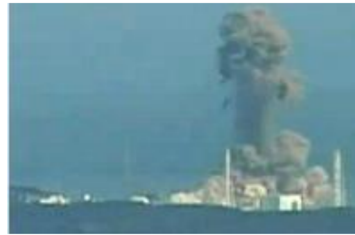
Accident de Fukushima (11/03/2011) : INES 7/7 Explosion d'hydrogène et rupture de confinement. Dissémination des radionucléides dans l'atmosphère, évacuation des populations.
