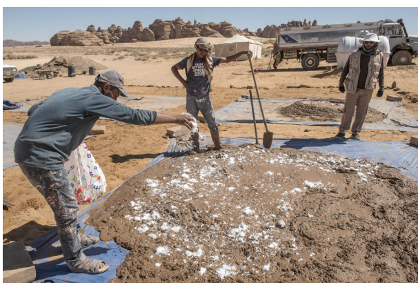
Fig. 4. La préparation du mortier de terre, ajout du dégraissant (© H. Raguet).
