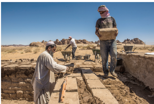
Fig. 6. Restauration de l'un des murs de la porte Sud-Est à l'aide de briques crues (© H. Raguet).
