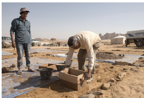
Fig. 5. Démoulage d'une brique par Ibrâhîm as-Sabhân avant sa mise à sécher pendant plusieurs mois (© H. Raguet).
