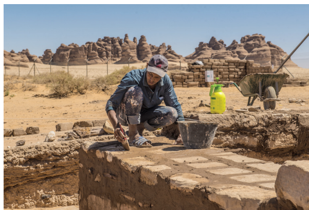
Fig. 7. Finition des joints au mortier de terre sur l'un des murs restaurés de la porte (© H. Raguet).
