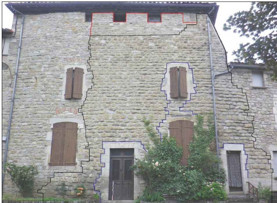
Fig. 6 – Façade de la maison ID 54 (cliché: C. Rivals). En noir: le rempart; en rouge: l'ajout de créneaux et d'un chemin de ronde (XIV e siècle); en bleu: le percement des ouvertures modernes. Le reste de la façade correspond à un rhabillage du parement externe (l'épaisseur des murs étant de 1.75 m sur l'ensemble de la façade).
