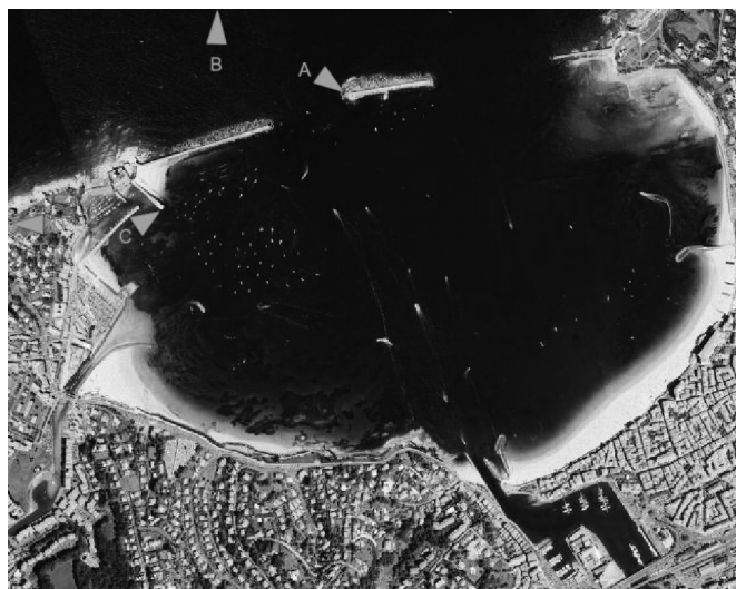
figure 1 : Situation de la digue de l'Artha dans la baie de St-Jean de Luz avec en A) la position des capteurs, B) la bouée de houle au large, C) le marégraphe de Socoa, D) le sémaphore de Socoa
