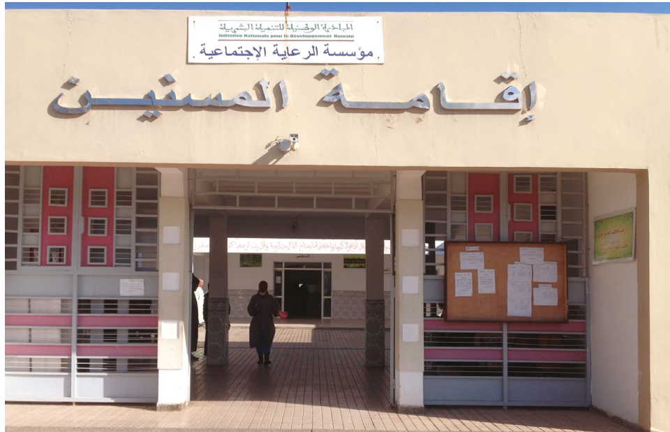
Façade extérieure du Centre pour personnes âgées de Meknès, Maroc, 2017. Mohammed Amar
