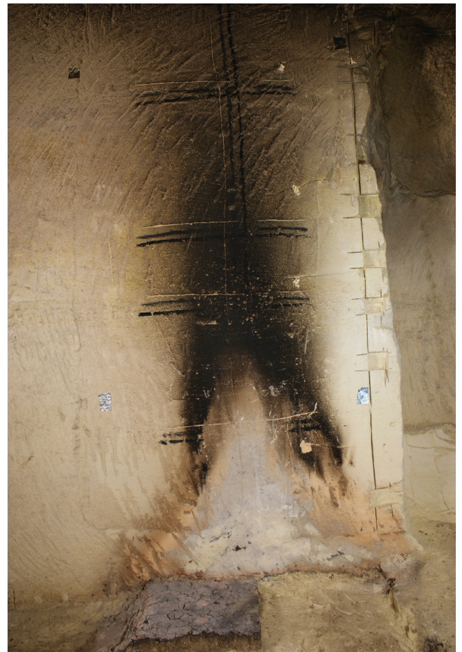
Fig. 7 - Expérimentation du programme IThEM. Après le feu, une coloration grise a été acquise par le calcaire, là où les températures ont été les plus élevées. La rubéfaction est périphérique (cliché C. Ferrier).
