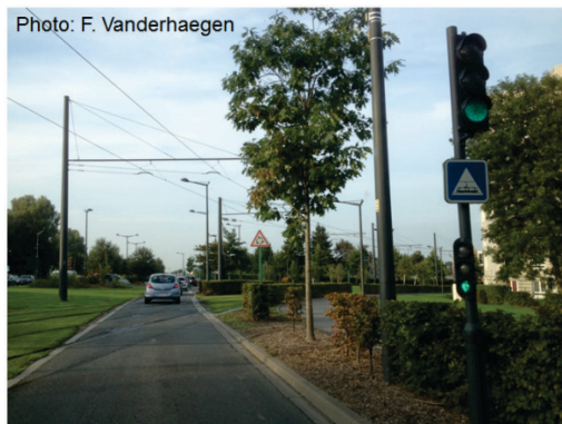
Figure 7. Croisement entre une route et une ligne de tramway
